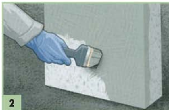
2 aplikácia adhézneho mostíka Knauf GB 120
