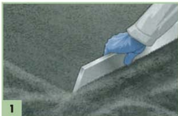
1 zrovnávanie drenážnej malty Knauf GB 100, Knauf GB 110
