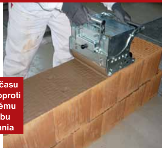
Pohľad na celoplošný spôsob nanášania malty pre tenké škáry
