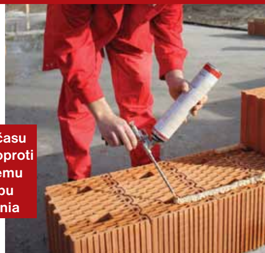
Pohľad na nanášanie peny DRYFIX extra pomocou aplikačnej pištole
